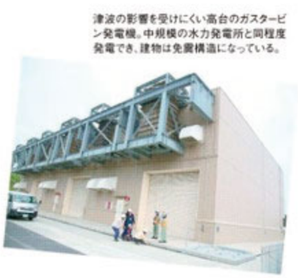
津波の影響を受けにくい高台のガスタービン発電機。中規模の水力発電所と同程度発電でき、建物は免震構造になっている。
